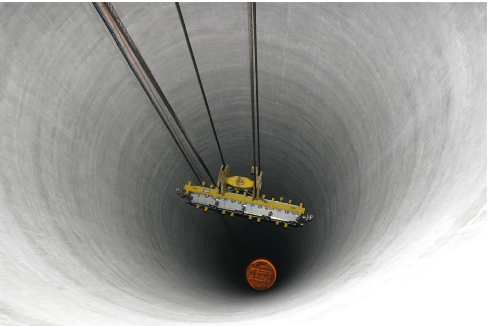
Spúšťanie urýchľovacieho modulu žeriavom z povrchu do podzemia v bode 4 LHC. Jeseň 2006.
